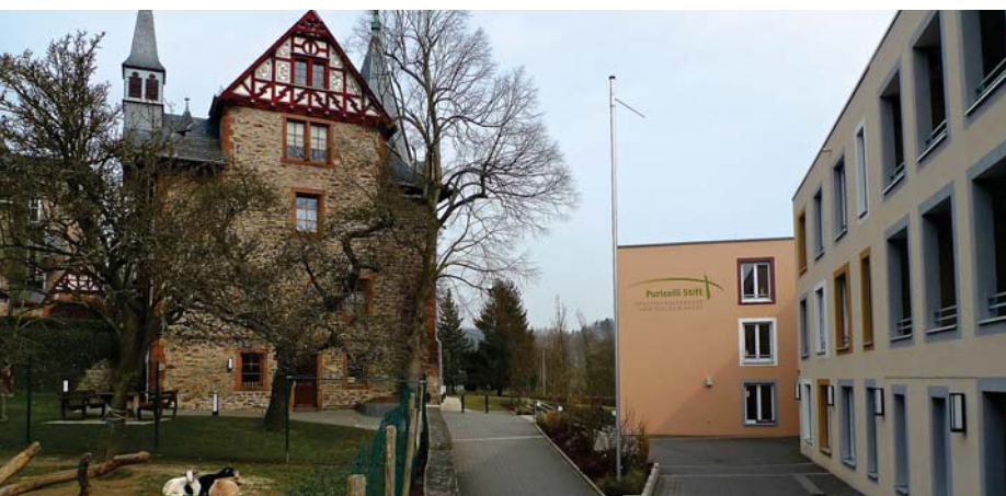
Betreutes Wohnen im historischen Gebäude, daneben das moderne Pflegeheim
