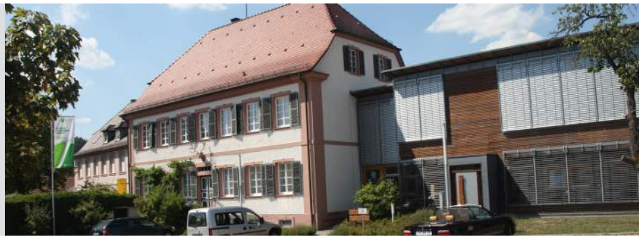
Das Wasgauer Forstamt: denkmalgeschützter Altbau mit neuem Seitenflügel in Holz.
