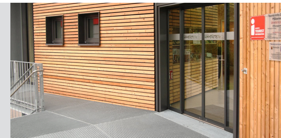
Quer und längs: Innen und außen sind die Wände mit Holz verlegt.
