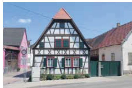
... die fachgerechte Sanierung rettet das einsturzgefährdete Haus in Neustadt.
