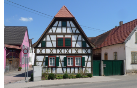
... die fachgerechte Sanierung rettet das einsturzgefährdete Haus in Neustadt.
