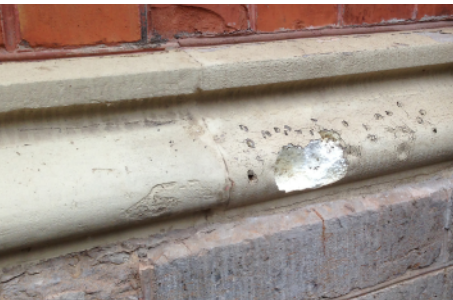
Nachhaltiger Unterschied: Links der Fuge Sanierung mit Naturstein, rechts Styropor.
