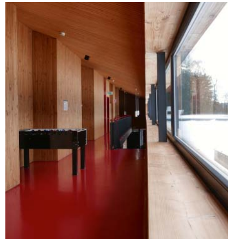
Der ganze Bau: massive Holzbohlen.
