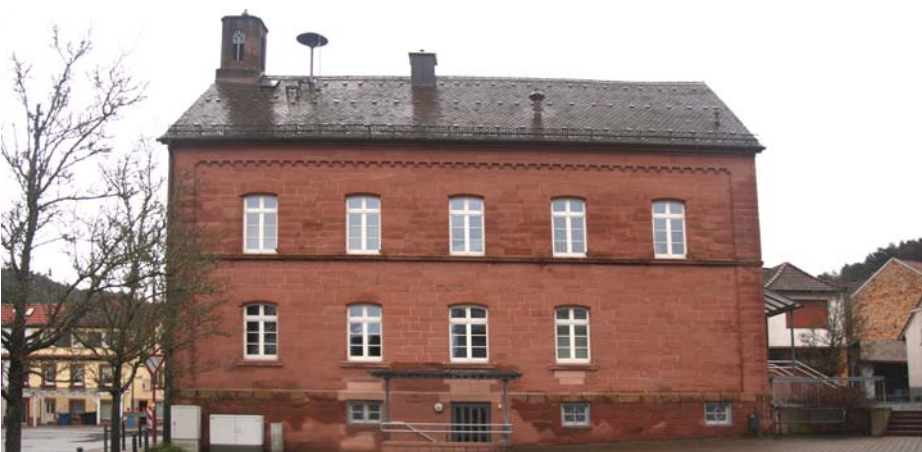
Der Nebeneingang von der Seite des Platzes aus mit Zugang zum neuen Keller.
