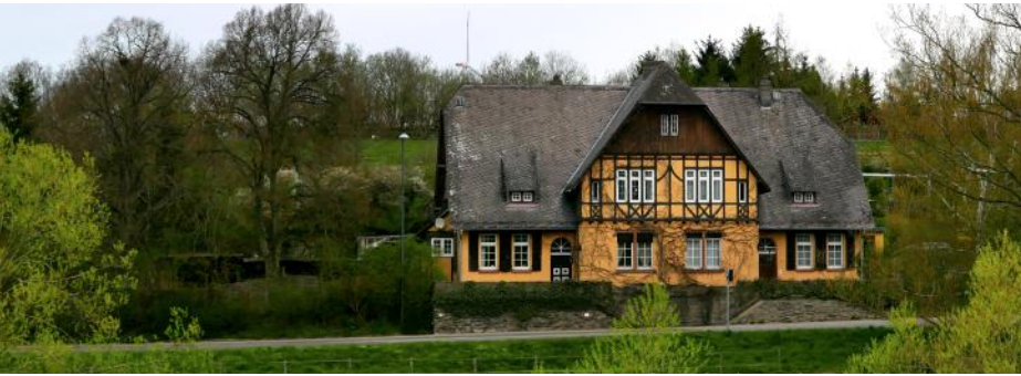
Die ehemalige Schule von Kisselbach bietet viel Platz für Praxis und Parken.
