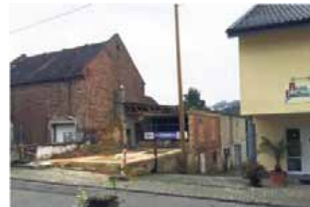
Manchmal hilft nur noch Abriss: Leerstand bietet Chancen für Neues.
