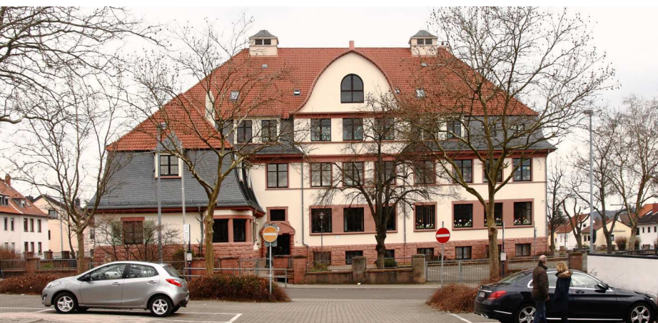
Die sanierte Grundschule in Eisenberg ist ein Jugendstilgebäude aus Sandstein.
