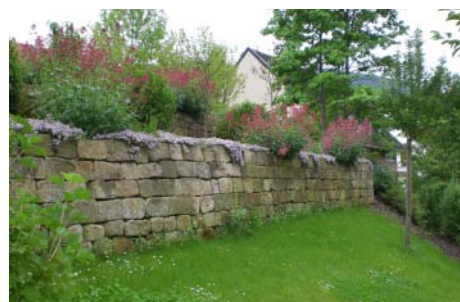
Trockenmauer aus Sandstein (hofmann_röttgen LANDSCHAFTSARCHITEKTEN BDLA)
