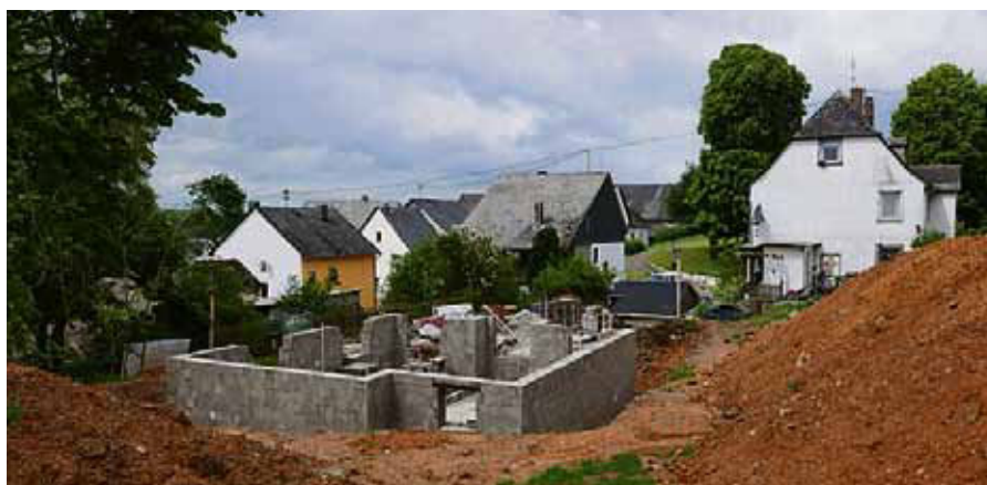
Der Neubau in Arbeit: Am Ende kommt es auf Fassadenstruktur und Farbgebung an.
