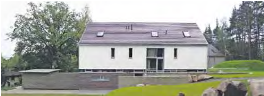
Die Längsseite des Neubaus mit dem bewaldeten Hang im Hintergrund.
