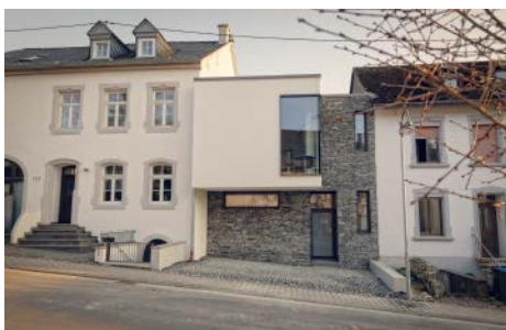
Eine Neubau erhält die historische Zeilenbebauung, Mertesdorf (CJS Architecte).
