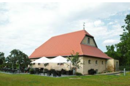
Denkmäler modern genutzt: Der Sandhof, Heidesheim (FAERBER ARCHITEKTEN GbR).
