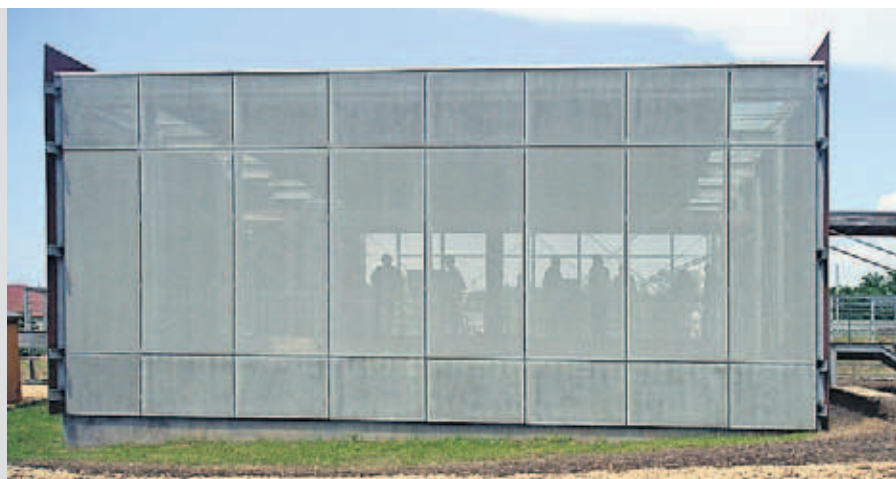
Das Streckmetallgitter sorgt für Witterungsschutz.
