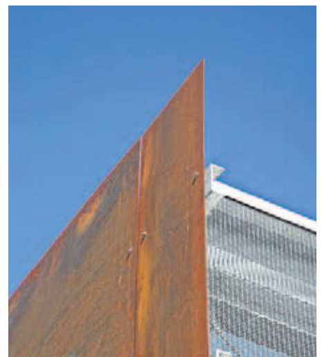
Rostroter Cortenstahl und Streckmetall.
