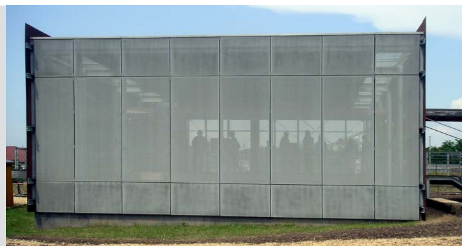
Das Streckmetallgitter sorgt für Witterungsschutz.
