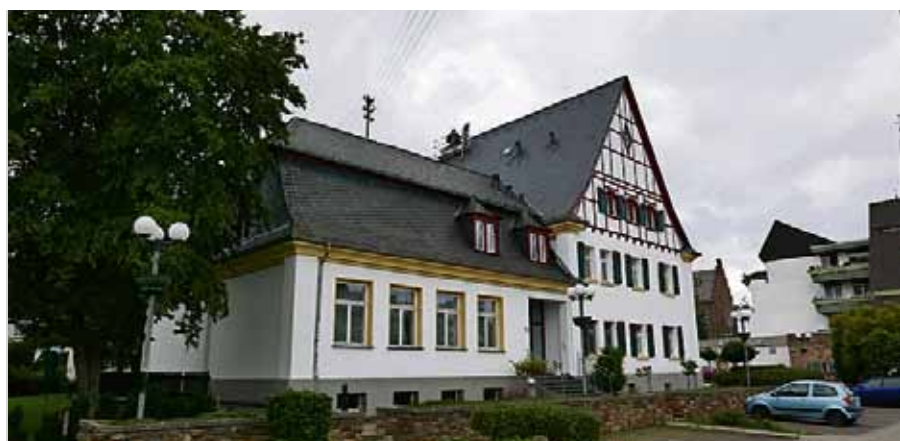
Der angebaute Schulsaal ist als Veranstaltungsraum durchgehend gebucht.
