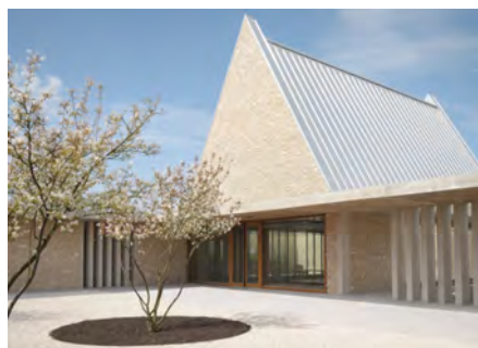
Die realisierte Aussegnungshalle in Frei-Weinheim der Architekten Bayer & Strobel.
