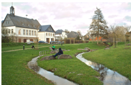
Der Bereich in der Ortsmitte von Kesselbach bietet heute hohen Freizeitwert.
