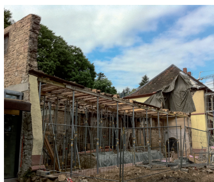
Der Westflügel wurde im Juli 2013 entkernt und aufwendig saniert. Hier befindet sich nun ein kleiner Saal.
