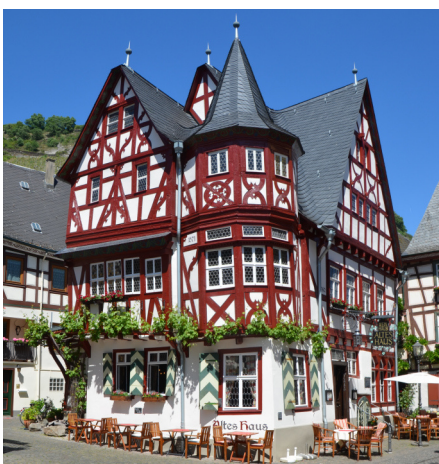
Das Alte Haus in Bacharach aus dem 16. Jhd., von Jäckel Architekten denkmalgerecht saniert
