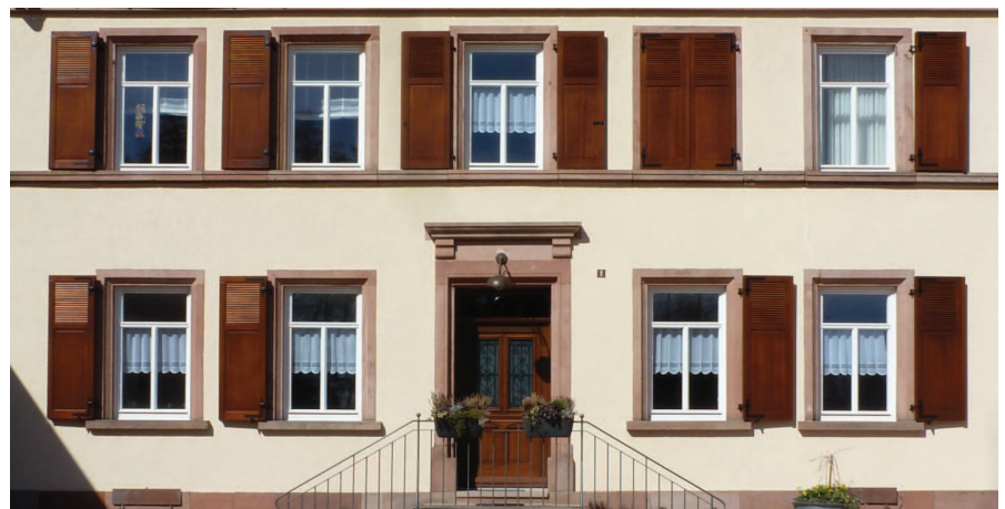
Beim Austausch der Fenster sowie dem Anbringen von Holzklappläden erhielten die Bauherren dieses Gebäudes in Kottweiler-Schanden ebenfalls Unterstützung aus Mitteln des Dorferneuerungsprogramms
