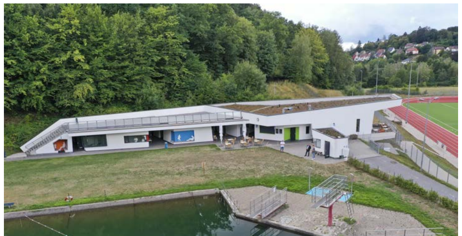
Das Schwimmbad in Otterberg ist seit 2015 fertig und vorbildlich in seiner Mehrfachnutzung. Es dient als Umkleide für den Sportplatz nebenan, hat ein Bistro und auf dem Dach eine Dachterasse
