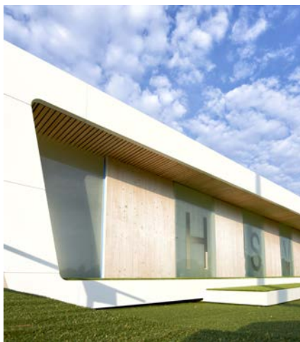
Seit 2013 hat der Herschbacher SV 21 ein neues Sportlerheim, Architekt war Markus Holzbach
