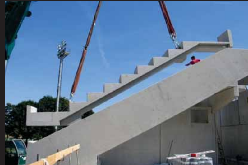
Verlegung der Fertigteile
