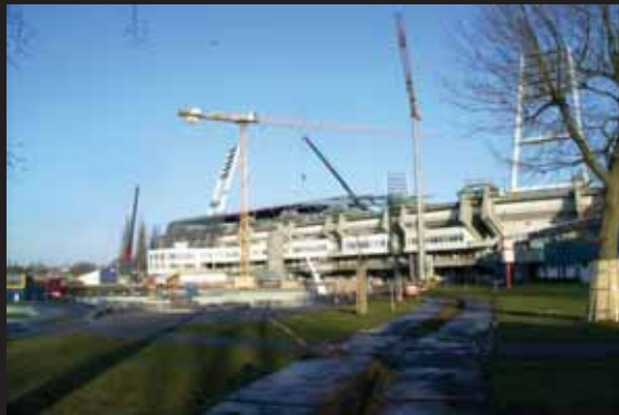
Südfassade und neues Dach
